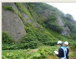
法面の落石・クラック確認
