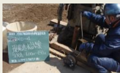
現場透水試験
